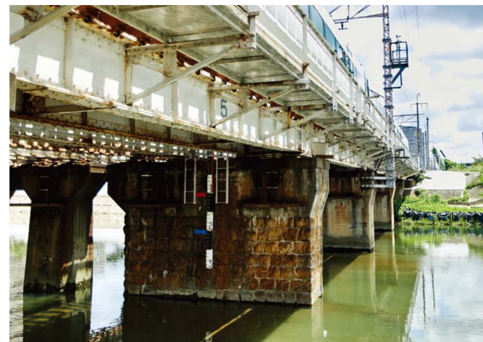
JR京都線の橋脚 芥川をまたぐ橋脚の一部分(写真手前)に石垣が転用
