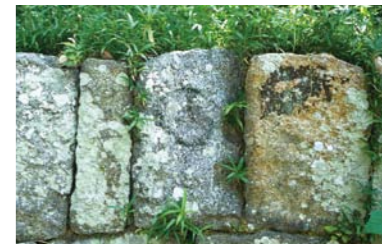
JR京都線の橋脚 芥川をまたぐ橋脚の一部分(写真手前)に石垣が転用
