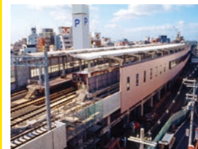
段階的に高架に切り替え
