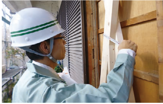
耐震改修設計のとおり施工されているか市職員が確認
