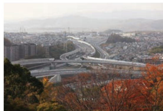
高槻ジャンクション・インターチェンジ
