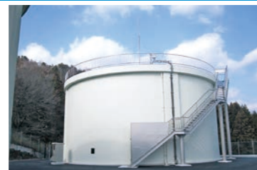
阿武山配水池2号池
