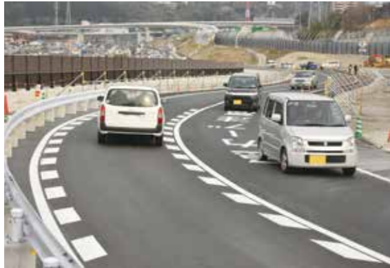
新 名神高速道路のアクセス道路 「南平台日吉台線」が開通
