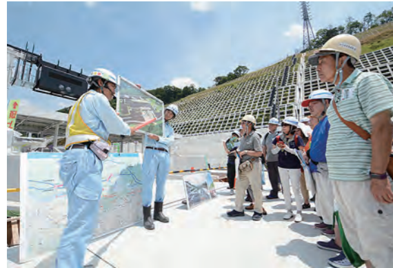
高槻ハイウェイフェスタ2017を開催 建設中の料金所を間近で見学
