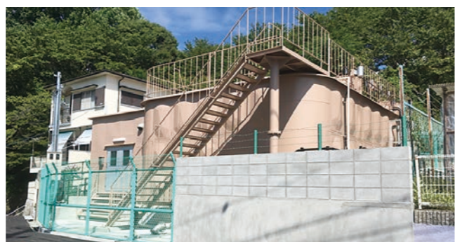
改築工事を行った大和第1配水池
