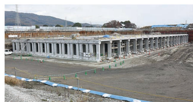
安満遺跡公園内雨水貯留施設
