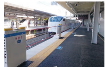
昇降式ホーム柵は、ロープによって線路への転落を防ぎ、電車が到着するとロープが上昇する 新改札口の外観
