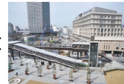
建設中の様子。地区の姿が一新した MUSEたかつきのオープン時の様子
