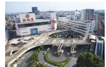
工事着手より6年かけてJR高槻駅南側の人工デッキのバリアフリー化が完了
