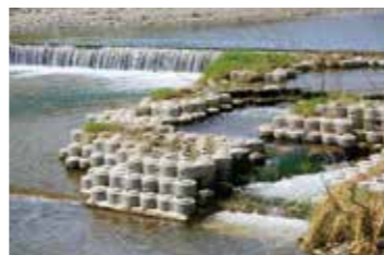
アユの遡上が見られる「魚みち」(魚が川を行き来できるようにするための通路)
