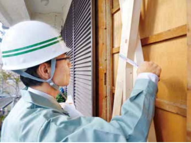
中間検査 耐震改修工事が設計図書のとおり施工されているか市職員が確認します
