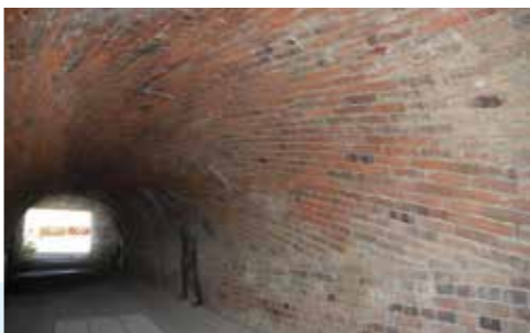
レンガ造りのアーチ橋
