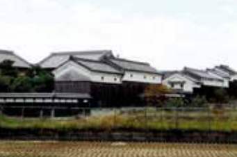
水害から財産などを守るために建てられた段倉。段々になった土蔵が特徴的
