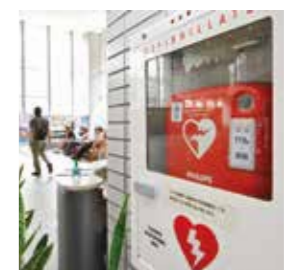
電源ボタンを押せば、使用方法を音声で案内してくれるAED
