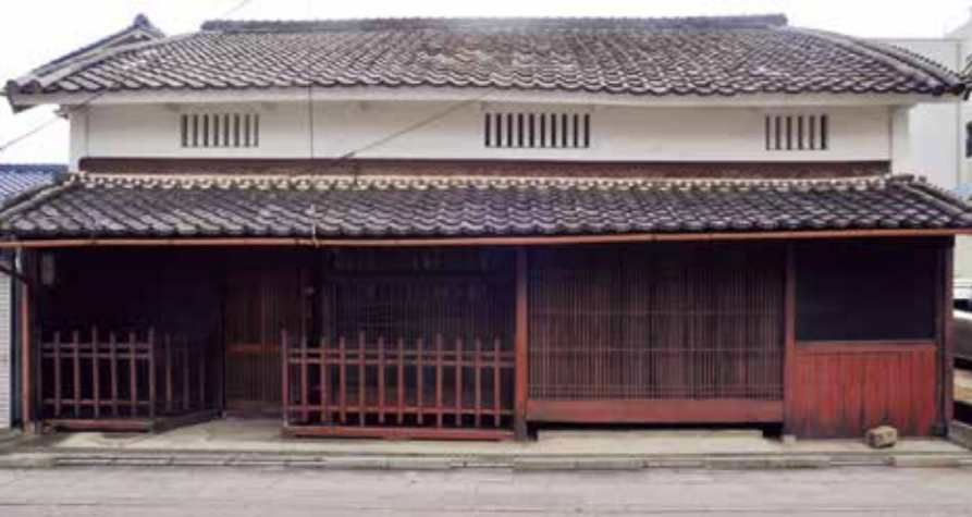
1階に「出格子」と呼ばれる格子のある出窓、馬が家の壁をけらないように守る「駒寄せ」という柵が腰の高さまで、2階は低い「厨子(つし)二階」、「卯建(うだつ)」なしという、高槻町家の典型的デザイン。バランスがとていい
