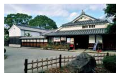
旧城郭内の城跡公園内にある旧笹井家住宅。岩崎さんいわく「高槻町家には珍しく、妻入り、本瓦葺きなどコトコテ系の意匠」
