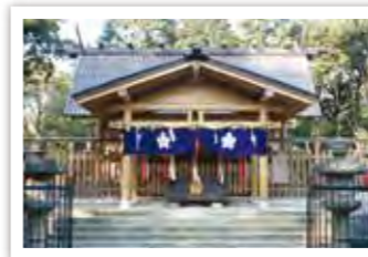
95%まで竹製の珍しい本殿。竹を薄くはいて貼り合せた特殊な建材を利用している
