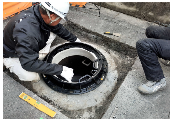
マンホール蓋の更新状況
