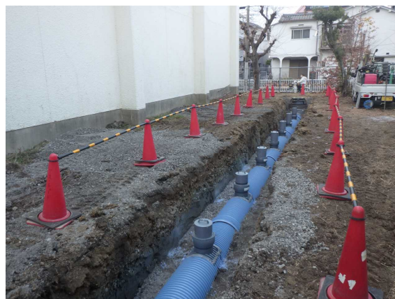
マンホールトイレ施工状況
