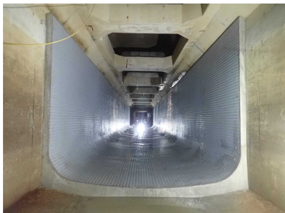
管更生工法による地震対策
