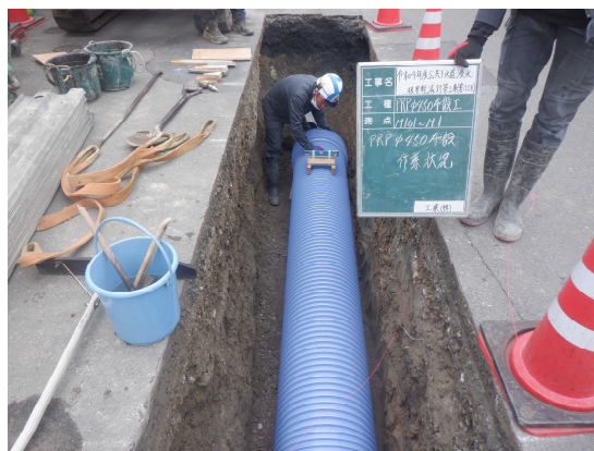
雨水管布設状況
