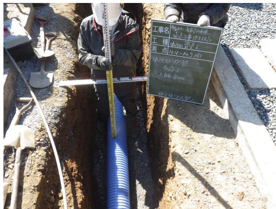
汚水管布設状況
