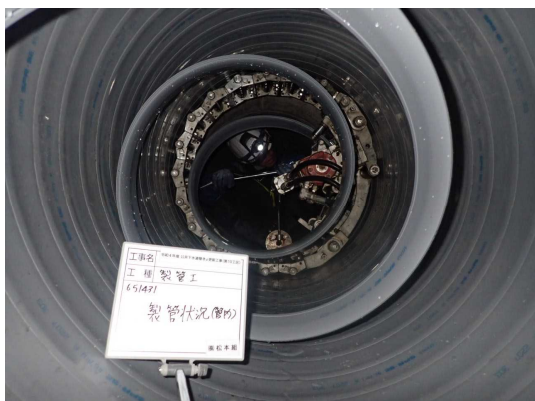
管更生工法による老朽化対策
