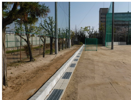
雨水流出抑制施設 (校庭貯留)
