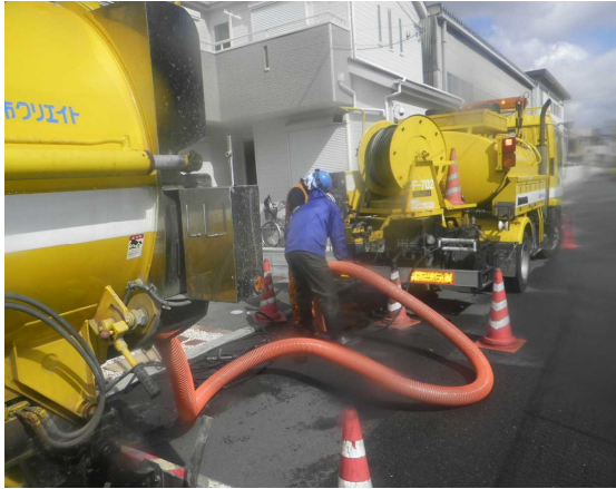
緊急浚渫による下水道の閉塞解消
