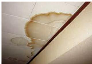
大阪府北部地震による屋根の損壊の応急処置として、屋根にブルーシートを敷いていても、雨漏りが生じる場合があります。雨漏りにより家内の壁や柱にカビが繁殖すると、家屋の劣化が進行する恐れがあります。
