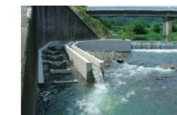
④ 正恩寺橋下流の魚みち
