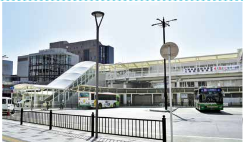
▲令和5年3月に整備工事が完了したJR高槻駅北駅前広場
