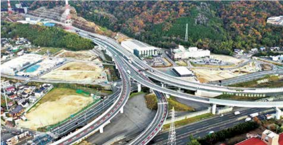
▲整備が進む成合南地区の様子（令和4年12月撮影）
