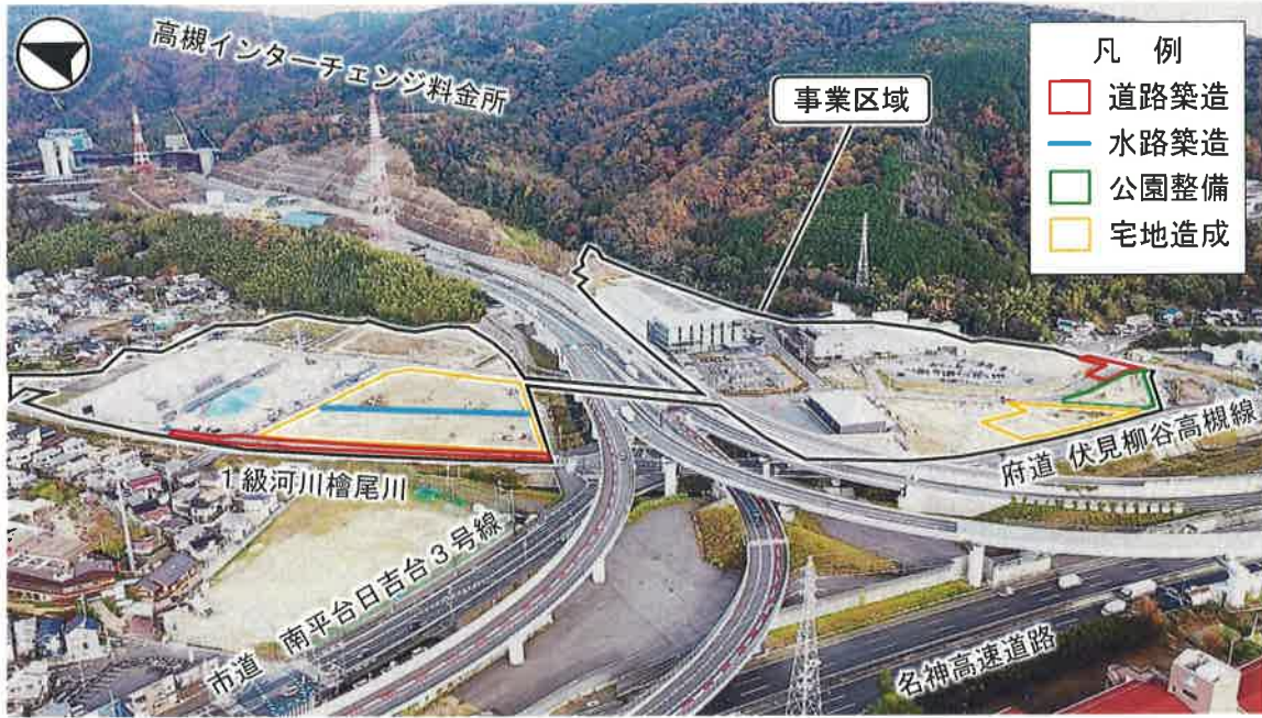
事業区域 全景（令和4年12月撮影）
