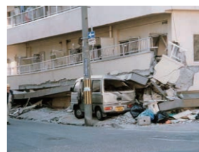
阪神大震災で倒壊したマンション
