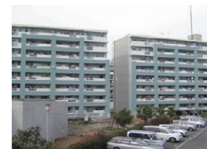
耐震化工事を 実施したマンション
