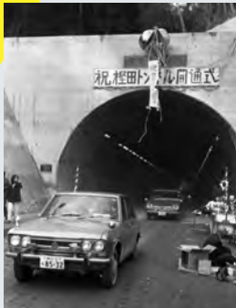
昭和48年、榎田トンネル開通式の様子
