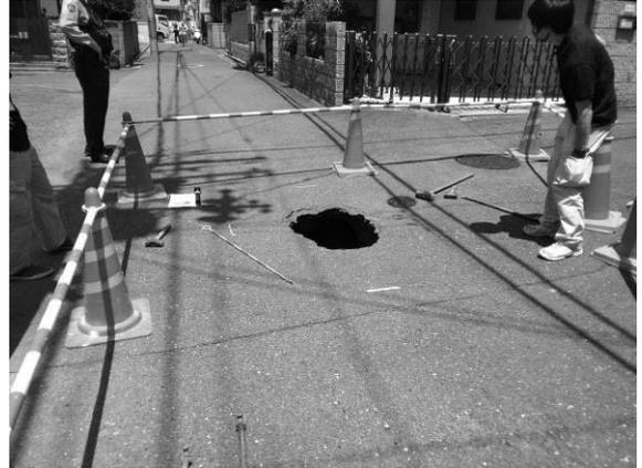
下水道管きよに起因する道路陥没
