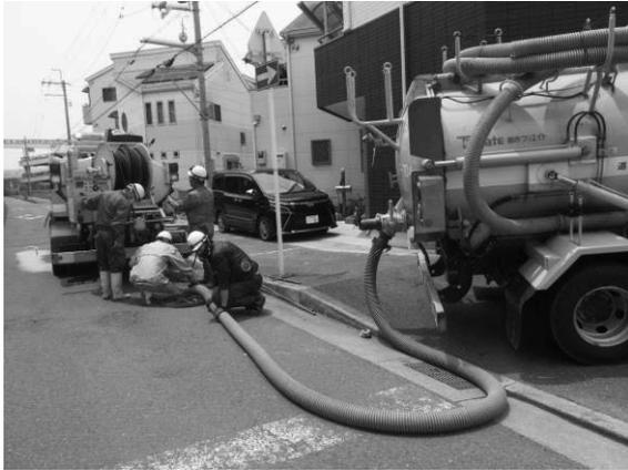
緊急浚渫による下水道の閉塞解消
