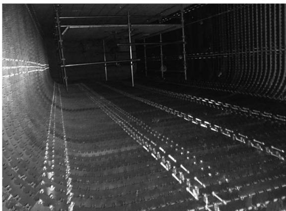
管更生工法による地震対策（施工状況）
