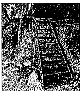
摂津峡(階段の補修)
