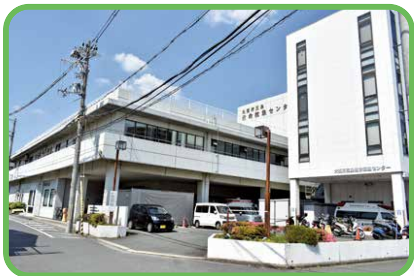
移転前の 三島救命救急センター
