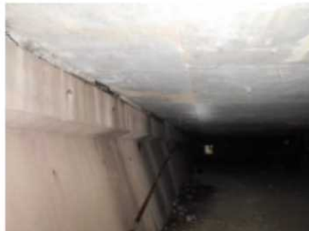
写真 6. ピット内コンクリート床版下面
