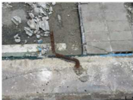
写真 4. 接合筋の台直し
