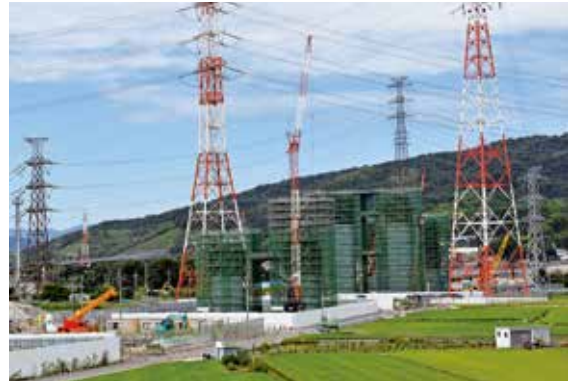
▲高架下を利用したスポーツ施設の設置の検討を進めていく新名神高速道路整備予定地（令和3年9月撮影）
