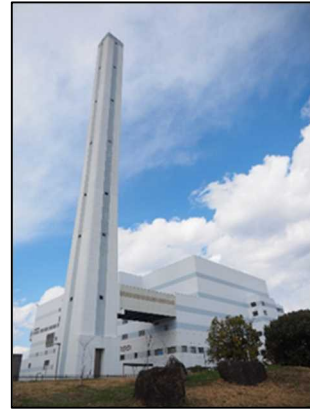
写真 エネルギーセンター第3工場
