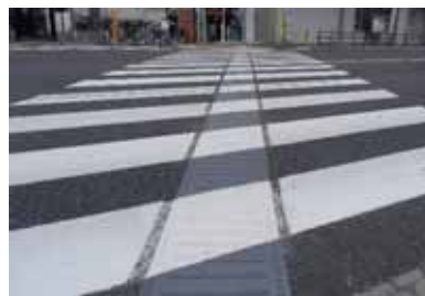
エスコートゾーン(※)の設置
