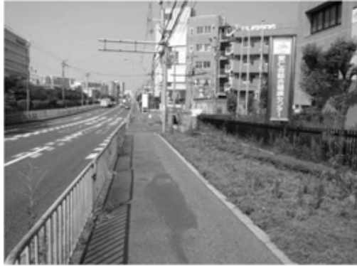
3 国道171号の現況
