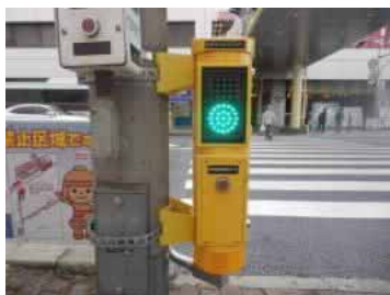
LED付き音響信号の設置
