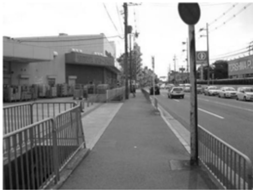
3 国道171号の現況
