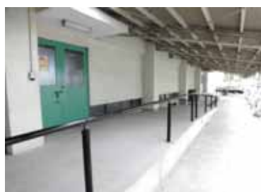
スロープ・手すりの整備
