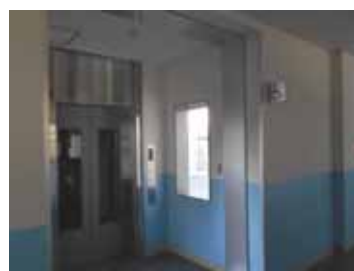
エレベーターの設置
