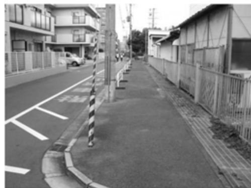
24 南芥川町5号線の現況
