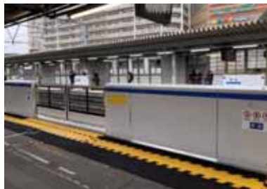
ホーム柵の設置
