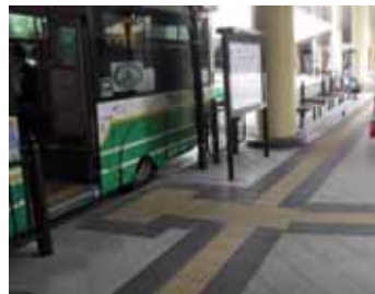
視覚障がい者誘導用ブロックの設置
