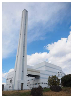
写真 エネルギーセンター第3工場
