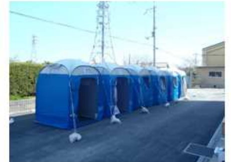
マンホールトイレ設置状況
