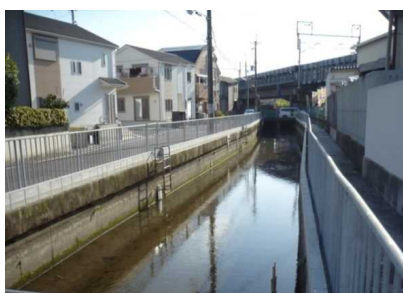
水路側壁のかさ上げ
