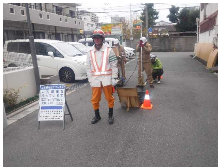
巡視点検の様子
