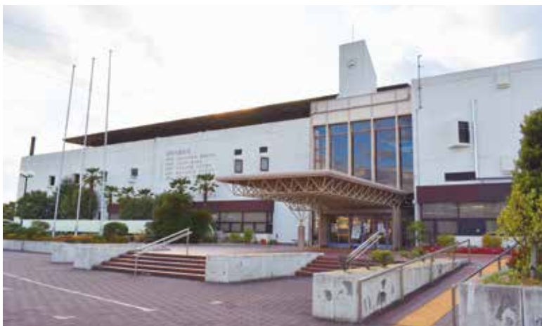
▲新たな指定管理者による管理が始まる総合体育館
