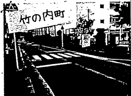
中学校前の横断歩道や、道路標示の補修
