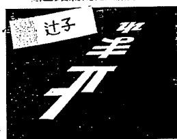
「止まれ」標示等の補修
