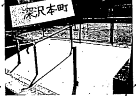
公園出入りに手すりを設置しスロープの改善
