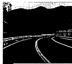
↑ 8月8日 仮設道路を2車線で利用開始
