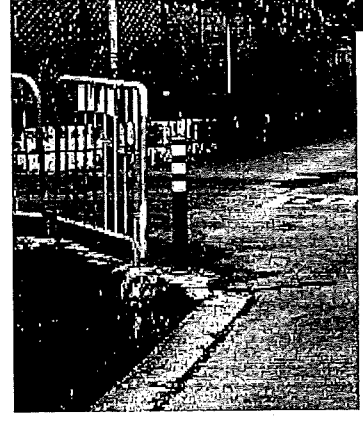
宮之川原元町の水路横にボール設置 ↓自動車の脱輪防止
