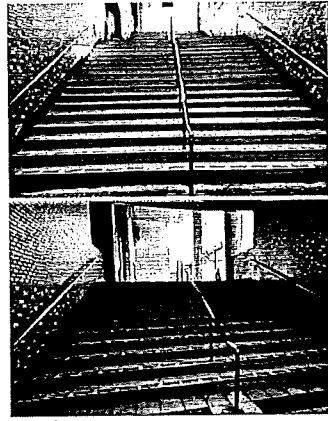
JR高槻駅南口からグリーンプラザ 3号館に繋がる階段(地下水漏れ) 階段表面を整備
