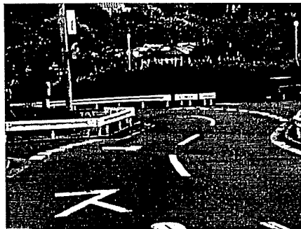
弥生が丘町 車道、交差点の安全対策
