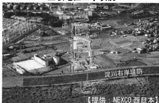
上牧地区工事状況
