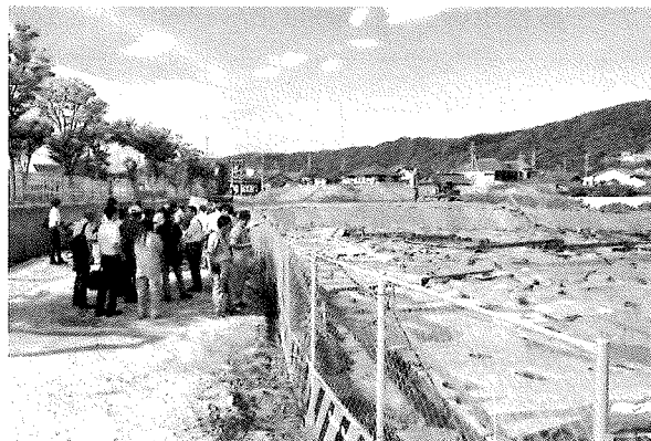
文化財調査(由義寺遺構)の現場視察の様子
