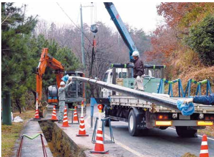
水道管路更新工事の様子
