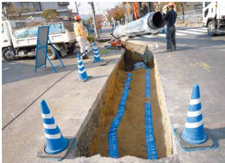
水道管路工事の様子
