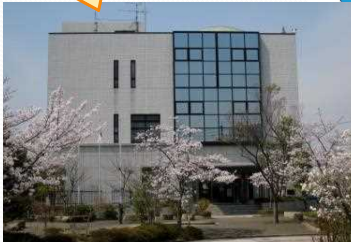
大冠浄水場（地下水）
