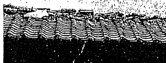
地震で被害を受けた住宅の屋根
