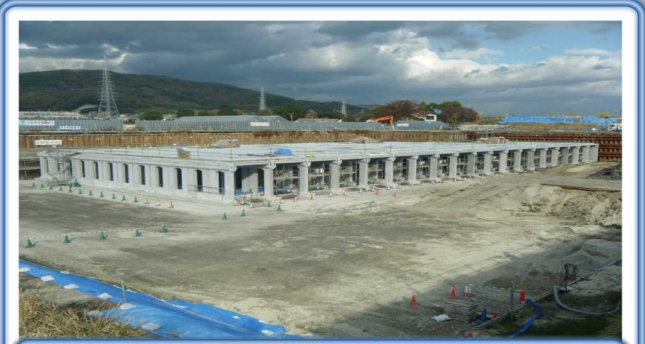
④ 平成28年8月 一次施工 据付完了
