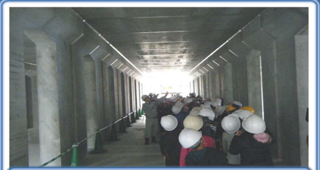
⑤ 平成28年12月貯留施設内部見学状況
