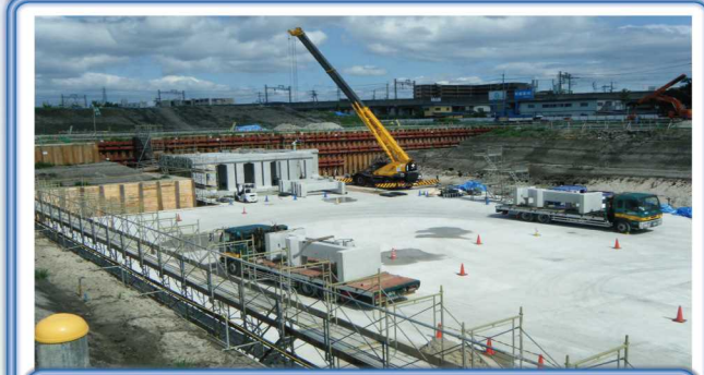
② 平成28年6月 プレキャストブロック据付状況
