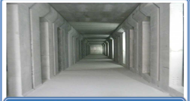
⑥ 平成29年3月 貯留施設内部完成状況
