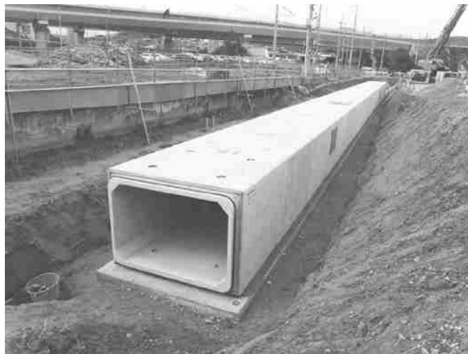
成合排水区 雨水函渠の整備
