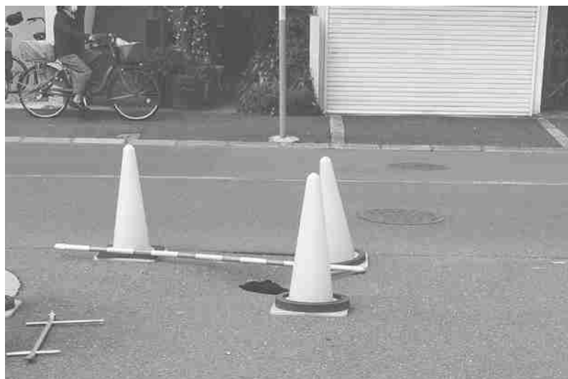
下水道管きよに起因する道路陥没
