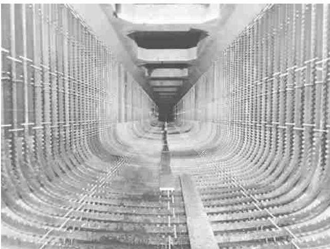
管更生工法による地震対策
