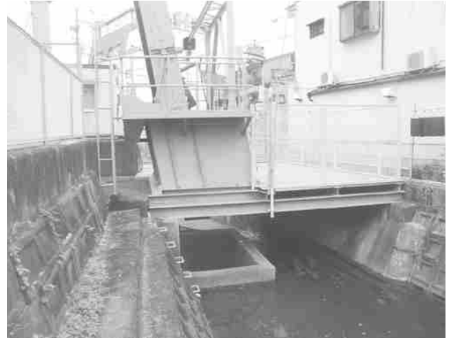
柳川取口の除塵機の更新工事
