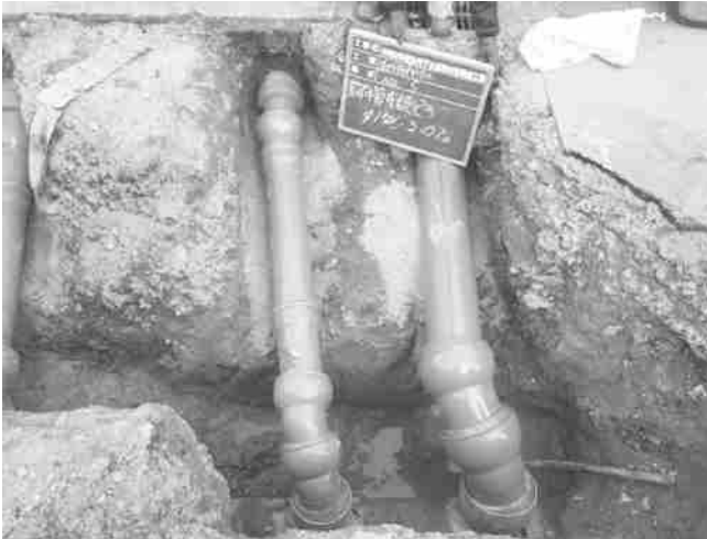
取付管の更新工事
