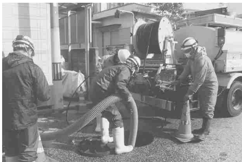
浚渫作業状況
