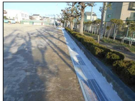
雨水流出抑制施設(津之江小学校)
