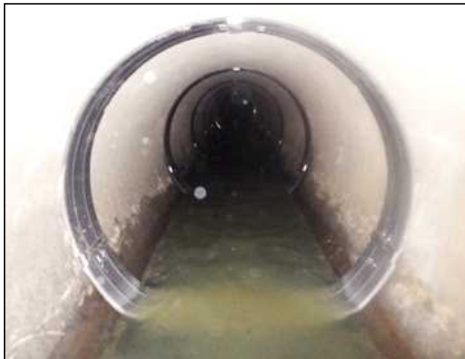
下水管継手の補強
