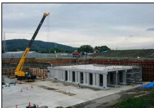
雨水貯留施設施工時 (安満遺跡公園内)
