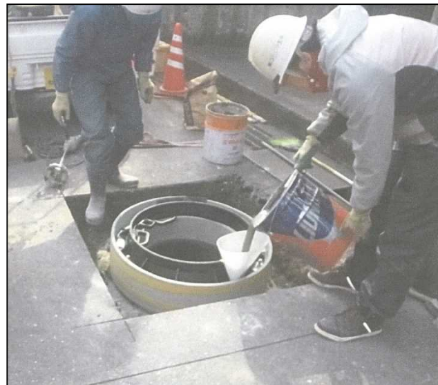
無収縮モルタル注入状況
