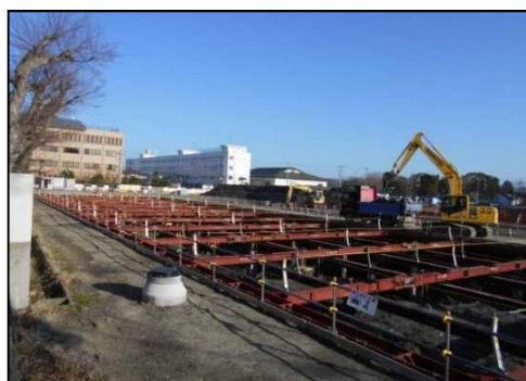
雨水貯留施設施工状況 (城跡公園内)
