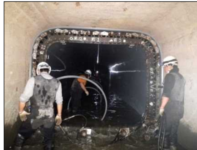
下水管更正工事
