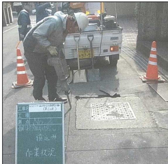
既設人孔撤去状況
