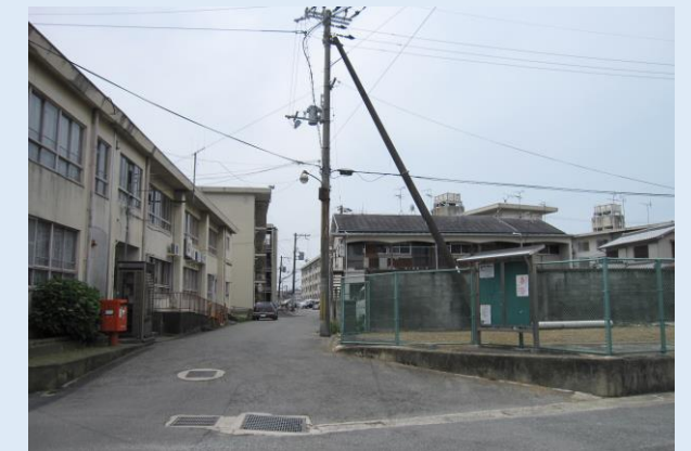
ふれあい文化センター分館北側の通路
