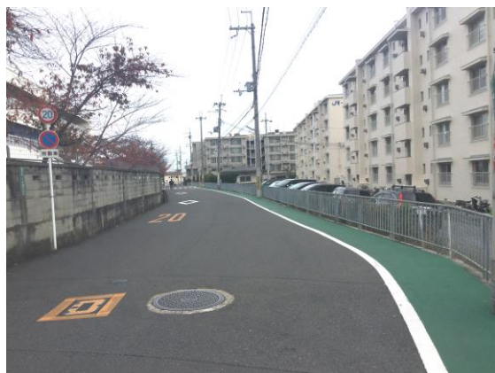
②敷地西側低層住宅
