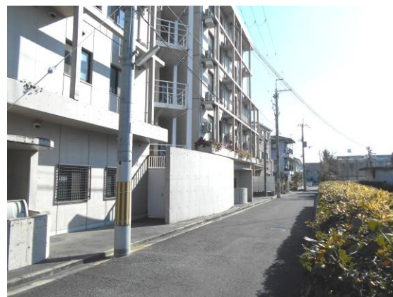
⑦敷地東側道路（北側）
