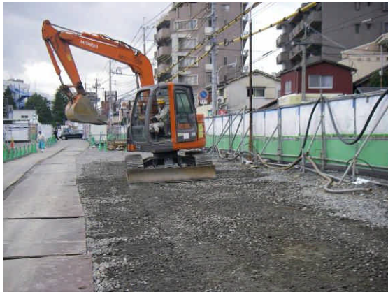
[古曽部天神線 道路工事の状況]
