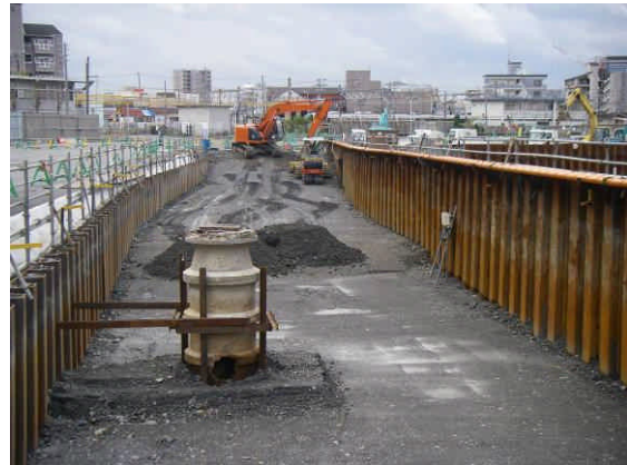
[古曽部白梅線 下水道工事の状況]
