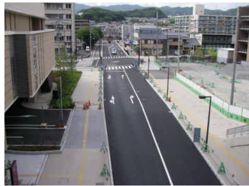
② 古曾部白梅線の工事状況
