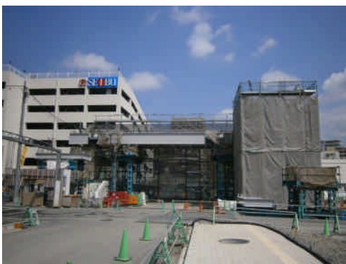
① Bデッキの工事状況
